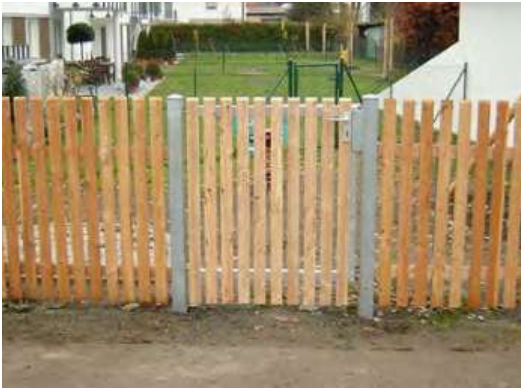
Gartentorrahmen mit Lärchen 4-Kant-Latten
