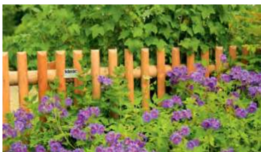
Staketen, abgeschrägt, Lärche
